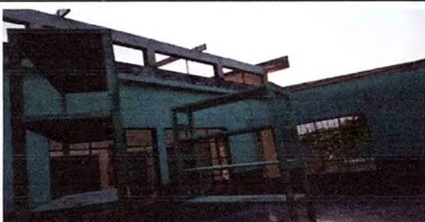
Foto 5: destroso de block para alineacion del techo
