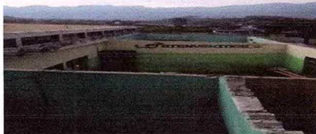
Foto 3: culminacion del desmontaje del techo
